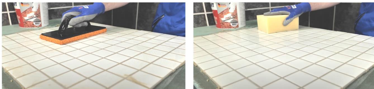
Рис. 24. Диагональными движениями шпателя убрать с поверхности плитки излишки затирки
